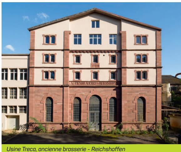
Usine Treca, ancienne brasserie - Reichshoffen
