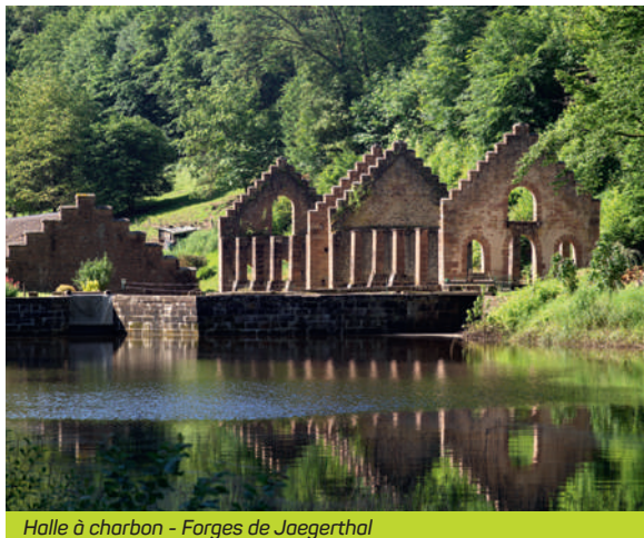
Halle à charbon - Forges de Jaegerthal
