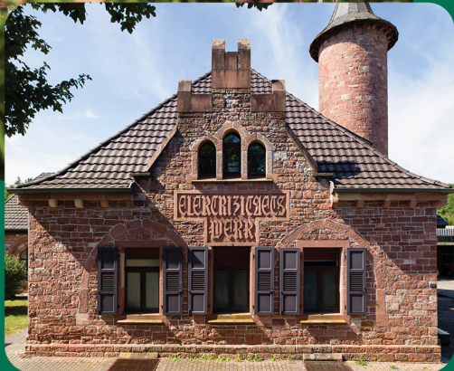
Usine d'électricité, → à Niederbronn-les-Bains
